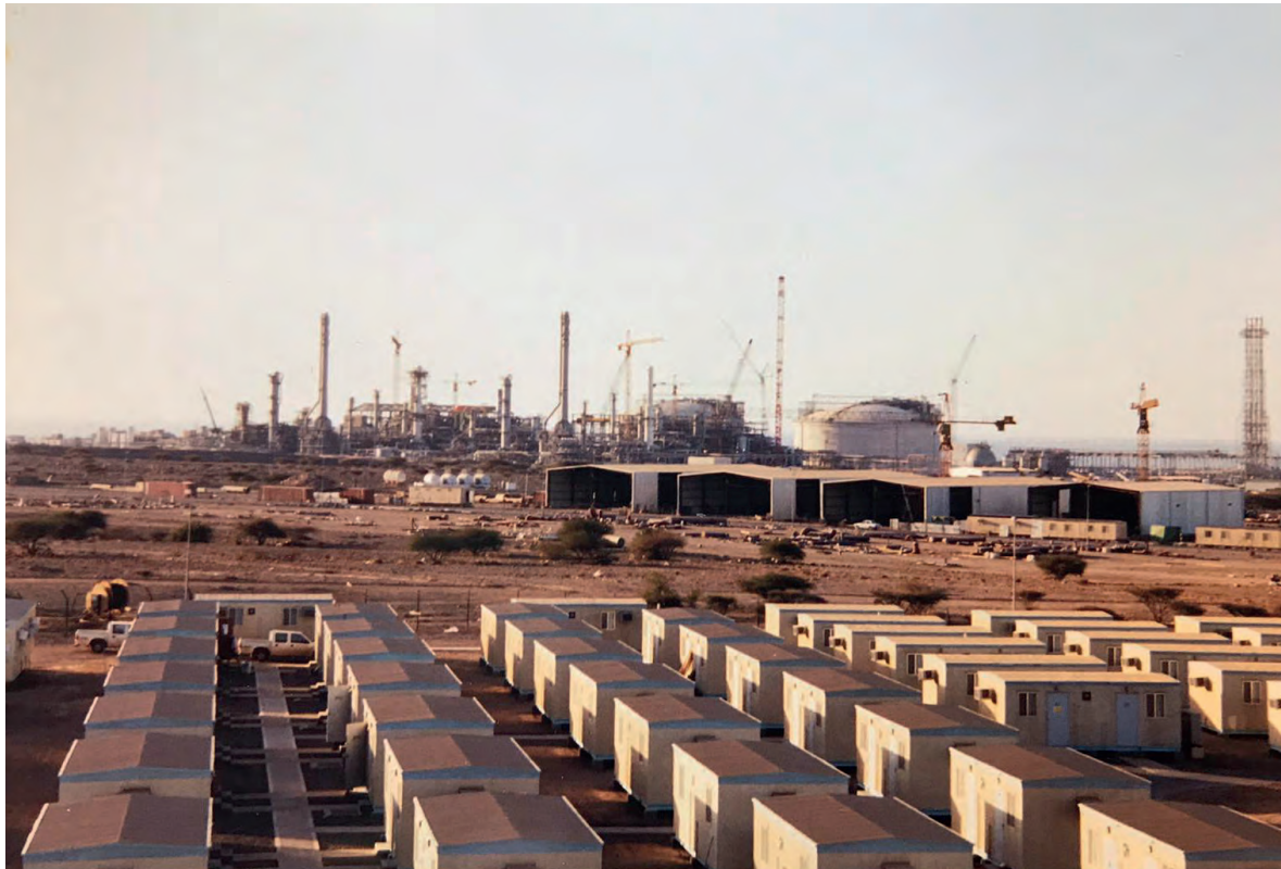
LNG fabriek met op de voorgrond de verblijfplekken
